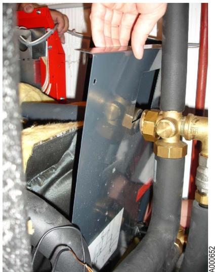
27. Remonter le tube flexible, le raccord du tube retour condenseur et le raccord départ chaudière.
