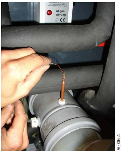
Démonter le thermostat fumée du panneau arrière (Pour la Suisse)
