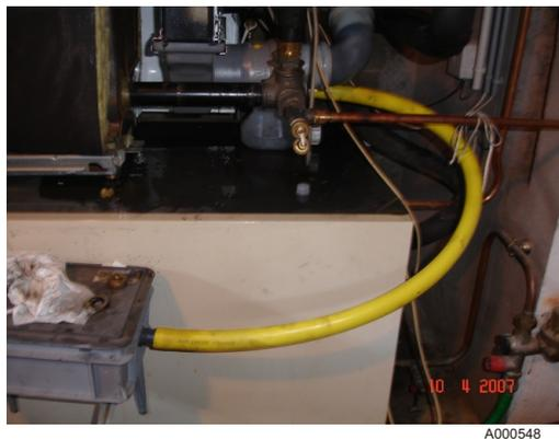
34. Remplir le siphon d'eau. Ne pas oublier de remettre le bouchon.
