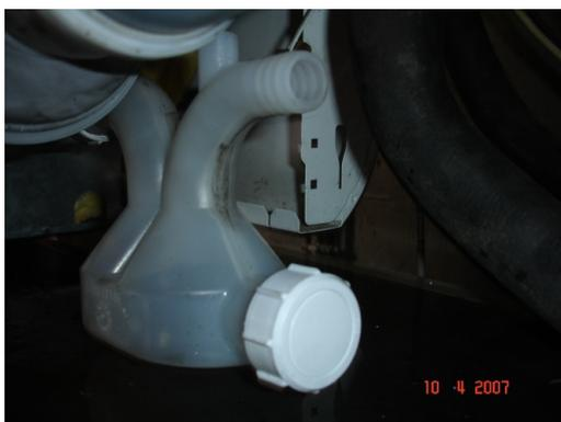
33. Fixer le tuyau d'évacuation des condensats sur le siphon.
