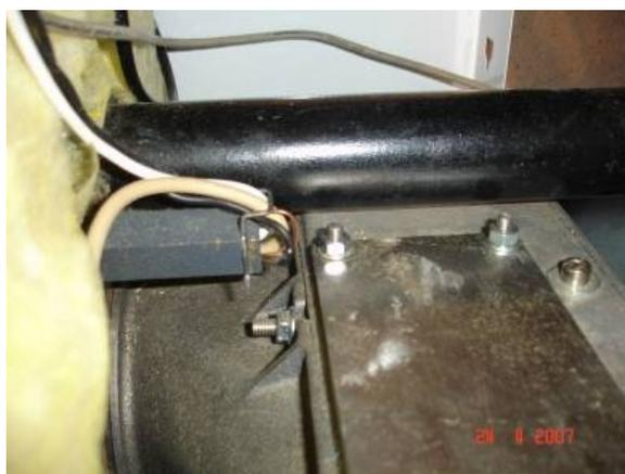
13. Démontez le tuyau d'évacuation des fumées.
